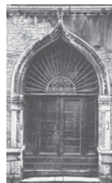
4. Venezia Porta presso il Ponte dei Calegheri
