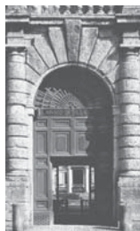
2. Roma Particolare della facciata di Villa Giulia
