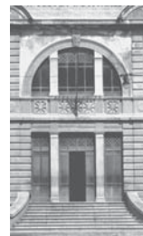
23. Potenza Particolare della Scuola Industriale
