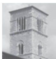
16. Terni Campanile della Chiesa di San Francesco
