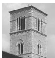
16. Terni Campanile della Chiesa di San Francesco
